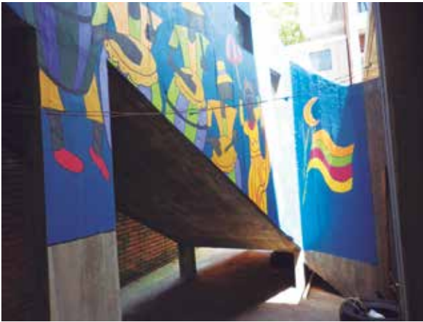
Figura 2. Pasillo sin tránsito.
